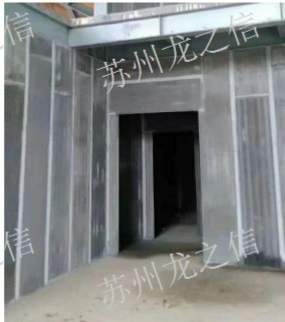
陶粒轻质隔墙板的特点：安全：主要是指其耐火性好。陶粒轻质隔墙板建材水化产物  $\text{CaSO}_4 \cdot 2\text{H}_2\text{O}$  遇到火灾时，只有等其中的两个结晶水全部分解完毕后，温度才能从其分解温度  $1400\text{C}$  的基础上继续上升，分解过程中产生的大量水蒸气幕对火焰的蔓延还起着阻隔的作用。与石膏、混凝土相比，其耐火性能要高 5 倍。我国 1998 年颁布的“建筑材料燃烧性能分级方法”和“建筑材料难燃性能实验方法”已将石膏制品列为不燃体。舒适：是指它的“暖性”和“呼吸功能”。陶粒轻质隔墙板的导热系数在，与木材的平均导热系数相近。材料的导热系数小，其传热速度慢；反之，其传热速度就快。导热系数大，人体接触时感觉“凉”，导热系数小感觉“暖”，这就使人们特别钟爱在室内使用木材。因陶粒轻质隔墙板具有与木材相近的导热系数，这也是许多国家大量在室内选用陶粒轻质隔墙板的原因。
